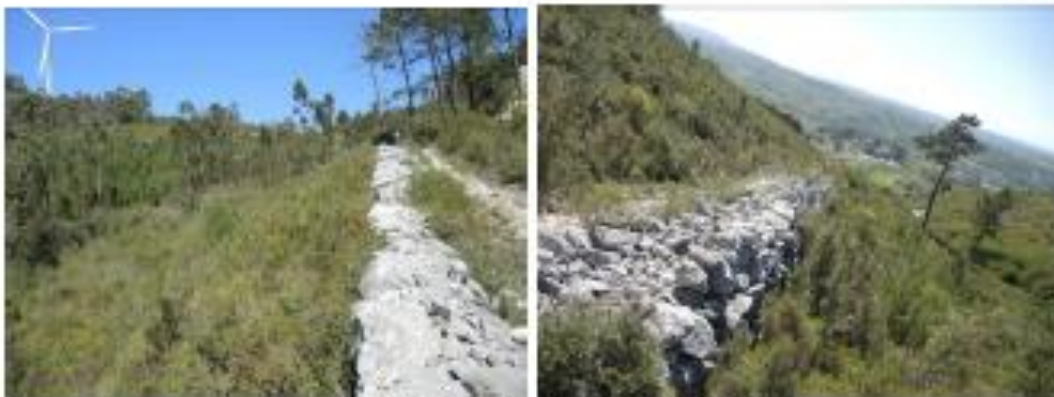
Caminho sustentado por espesso muro em pedra seca.
